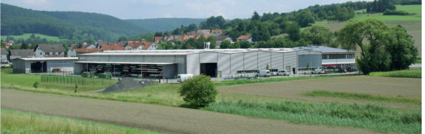
Der Frenger-Firmenkomplex im hessischen Groß-Umstadt zeigt die vielfältigen Möglichkeiten heutiger Energiekonzepte auf (Fotos: Frenger)
